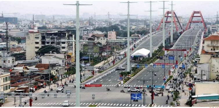
Công trình cáp ngầm hệ thống chiếu sáng Underground cable system for public lighting
