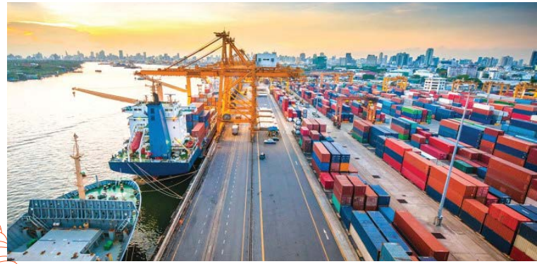
Công trình cáp ngầm tại cảng Underground cable system in ports
