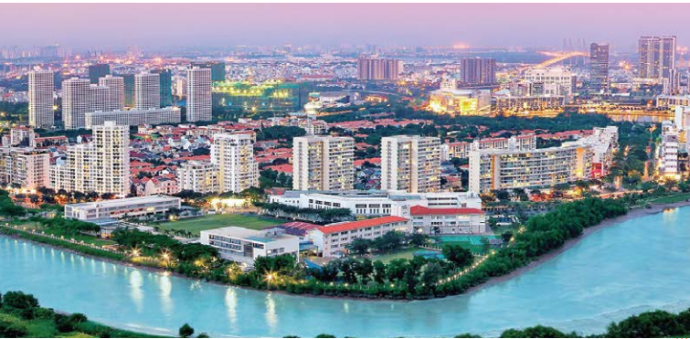
Công trình cáp ngầm tại các khu đô thị Underground cable system for urban areas
