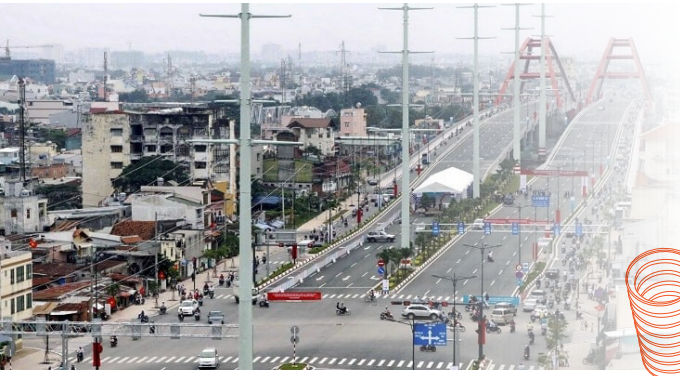
Công trình cáp ngầm hệ thống chiếu sáng Underground cable system for public lighting
