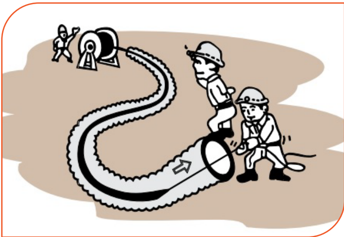
Luồn cáp dễ dàng, có thể bố trí hố ga cách xa nhau hơn Allows easy cable pull in and permits longer distances between handholes
