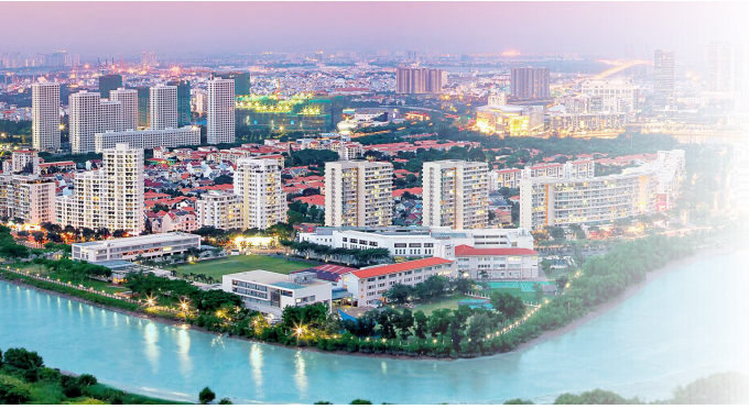
Công trình cáp ngầm tại các khu đô thị Underground cable system for urban areas
