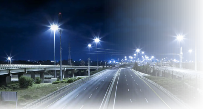
Công trình cáp ngầm trên đường cao tốc Underground cable system for highways
