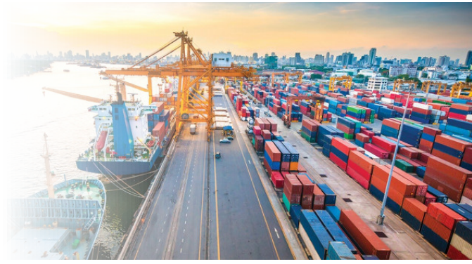
Công trình cáp ngầm tại cảng Underground cable system in ports
